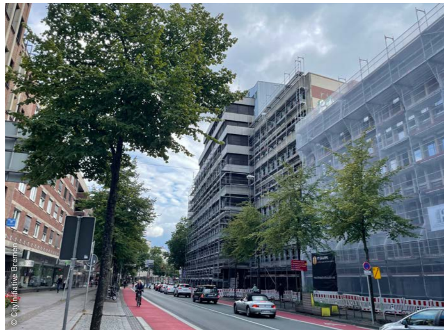
// Ansicht Martinistraße: Umbau des ehemaligen Greensill-Gebäudeensembles zu Wohnraum
