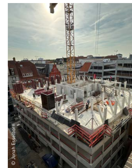
// Baustelle des Essighauses (Juli 2024)
