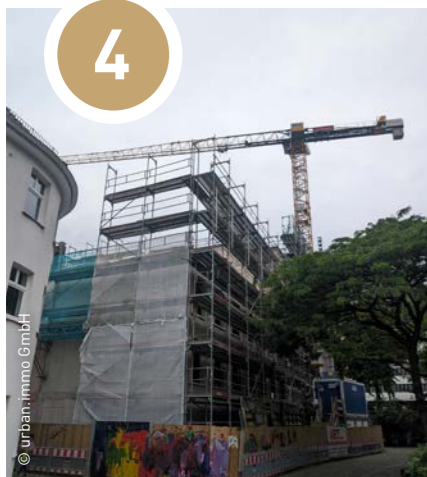
// Bauarbeiten in der Balgebrückstraße / Ecke Hohe Straße
