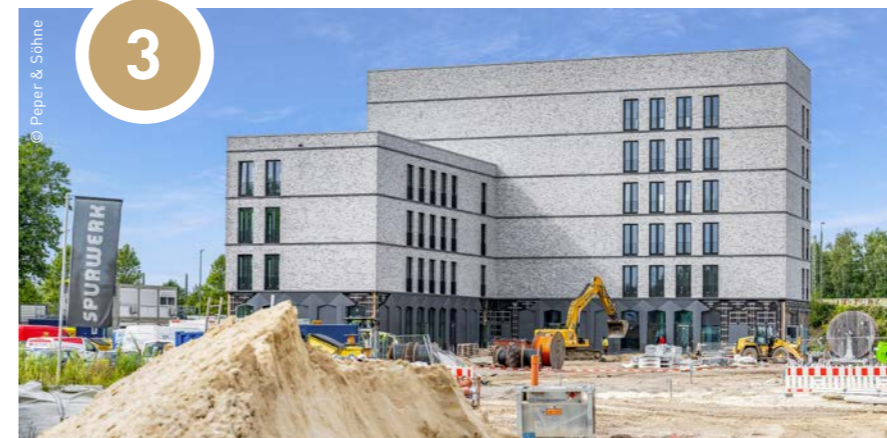
// SPURWERK, Fertigstellung der Arbeitswelt A
